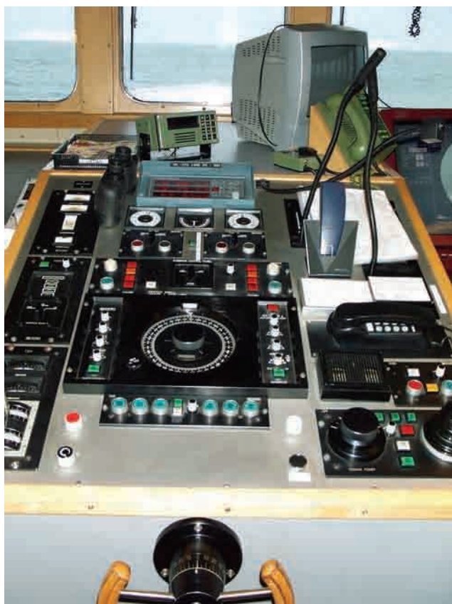
Figur 13: Navigations og styringsudstyr på Broen
